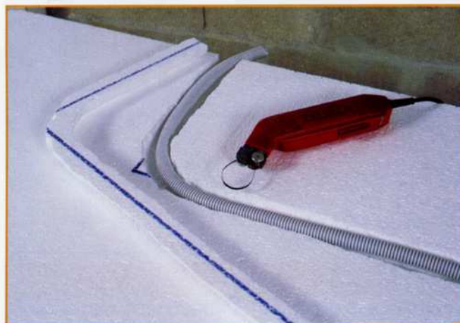
Photo 1 : Découpe thermique pour le passage des gaines
