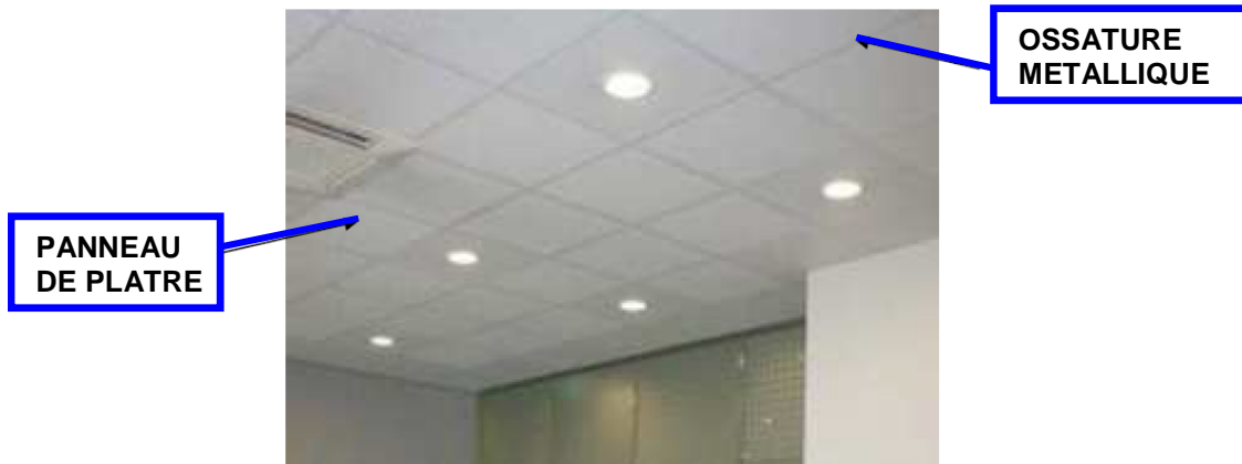
Source : Projet pilote GtoG Paris (France) - GtoG DB1 HANDBOOK Best practises deconstruction
