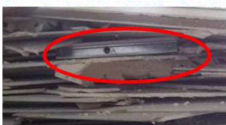
Ossature métallique laissée entre 2 plaques de plâtre
