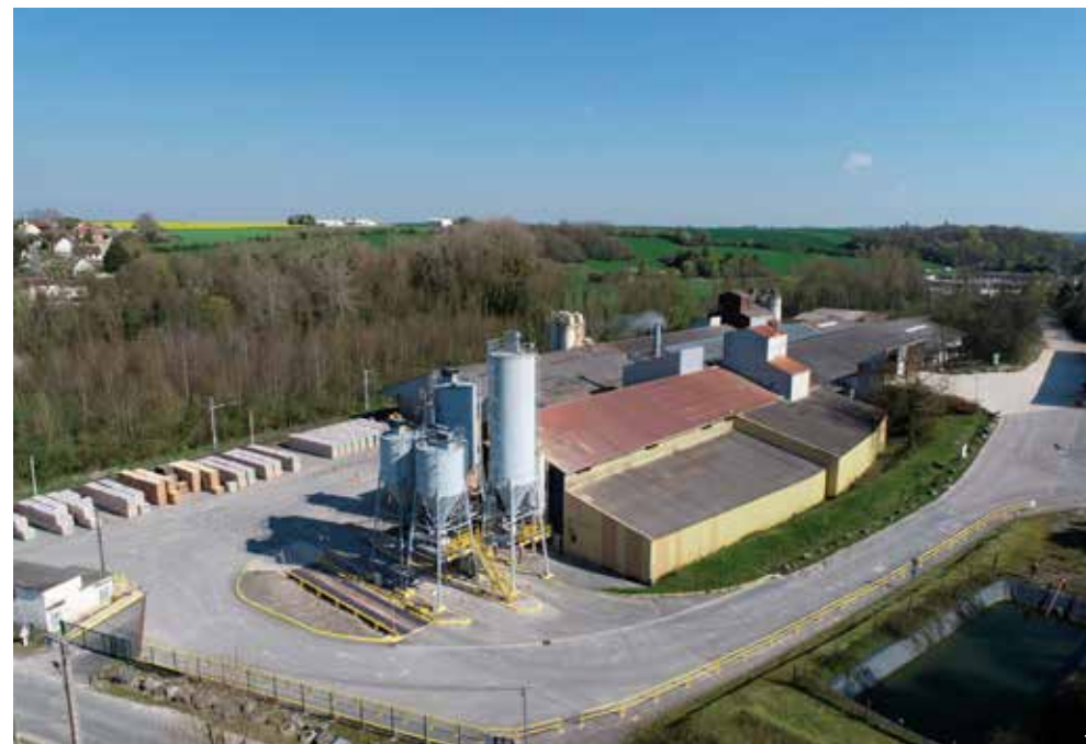
▲ Usine de traitement des argiles kaoliniques (Poigny, 77).
